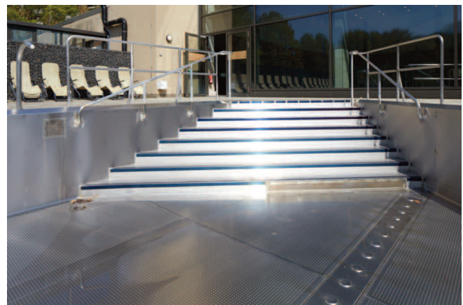
Abbildung 5: Beckenentleerung mit System
